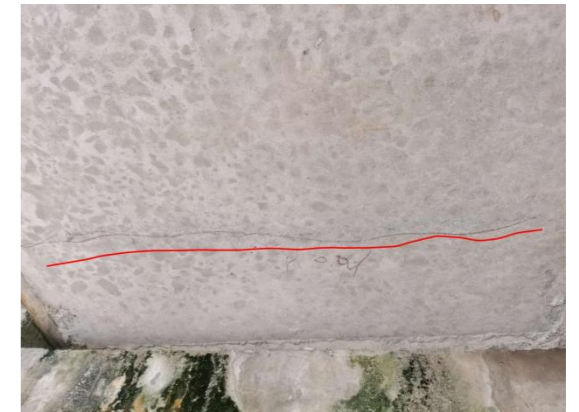
图 3-2: 南靖互通 7#桥 2-1 空心板: 距 1 号墩 0m 起, 距右侧 0m 起, 板底横向裂缝; 数量: 1 条, 长度: 0.8m, 宽度: 0.13mm。
