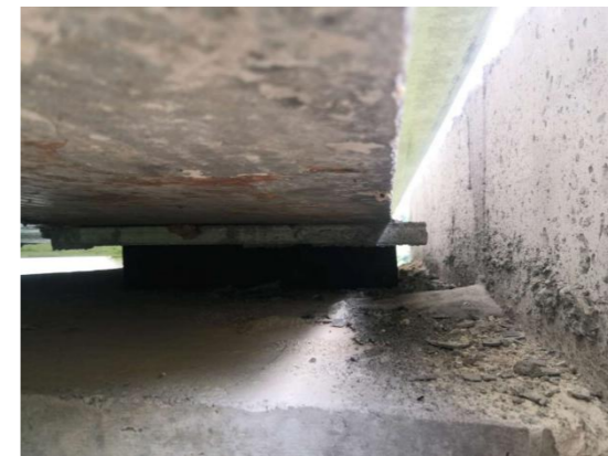
图 3-15: 斗米 3#大桥 (下行) ZZ-9-9-8 支座: 往左侧串动; 数量: 1 个, 位移: 0.01m。
